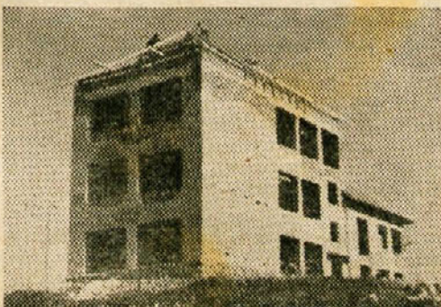
Šola na Dolžu med gradnjo
