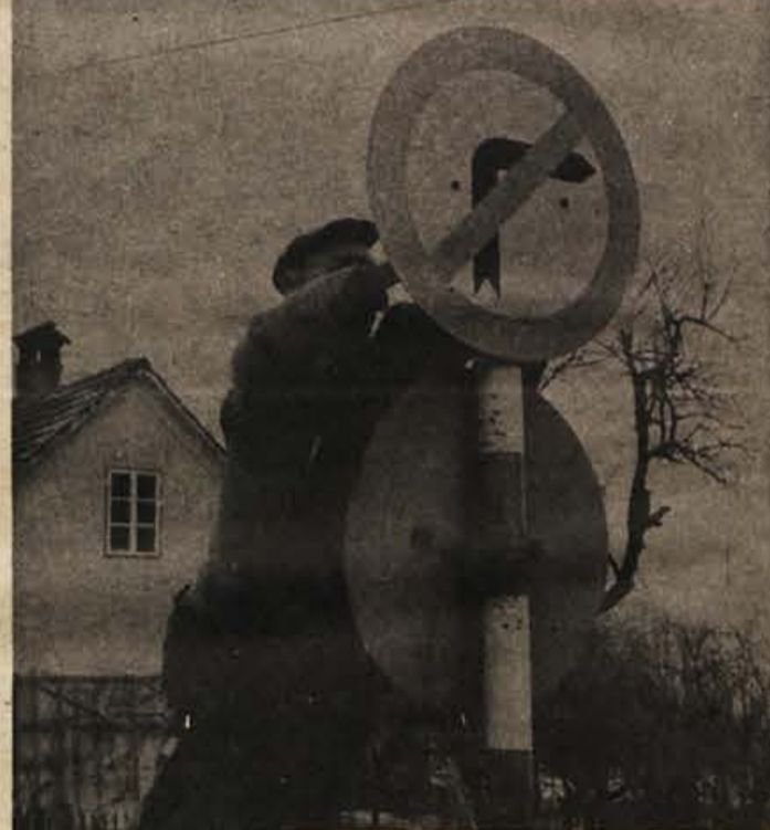
Izrabljene, neustrezne in poškodovane prometne znake po Novem mestu so delavci Komunalnega podjetja ob izteku starega leta zamenjali. To bo precej pripomoglo k varnejši vožnji. (Foto: Ria Bačar)
