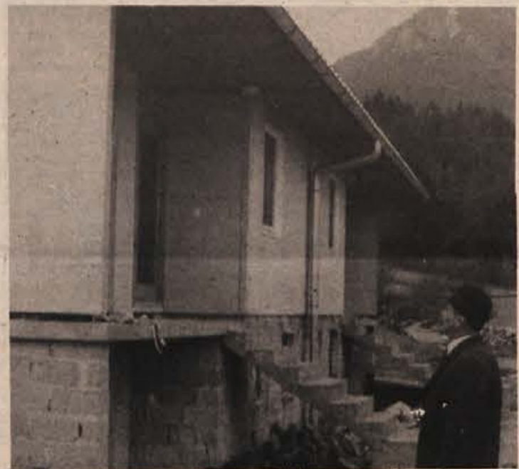
Okoli prvega maja je Vas-Fara pridobila montažno stavbo, v kateri so 4 stanovanja za učitelje, in sicer 2 družinski stanovanji in 2 garsonjeri. Veljala so okoli 700.000 din. Denar zanje so prispevali solidarnostni sklad, TIS in osnovna šola. (Foto: J. Primc)
