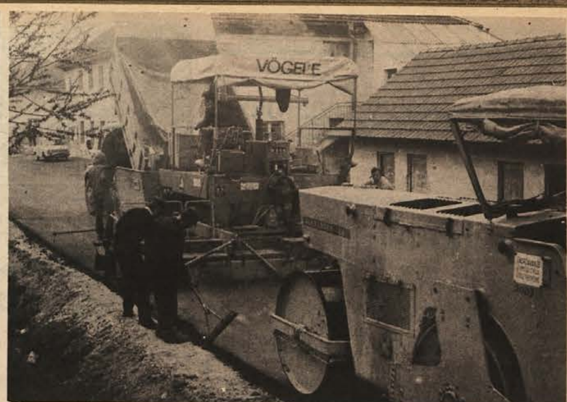
Pred prvomajskimi prazniki so v Veliki Loki dobili prvih 900 metrov asfalta v naselju. Občani že težko čakajo, da bi videli stroje tudi na odseku ceste proti Štefanu. Vse štiri krajevne skupnosti: Čatež, Štefan, Velika Loka in Šentlovec so pripravljene prispevati tudi 100 tisočakov, ki jih bodo dobile od sanoprispevka. (Foto: Zeleznik)
