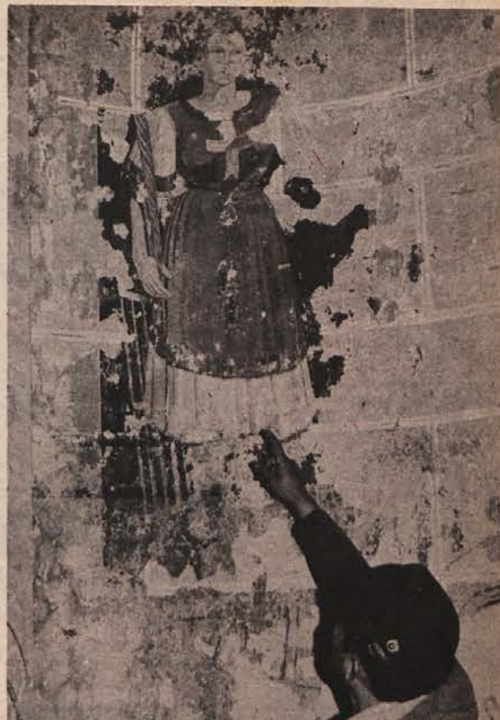
Izpod beleža v cerkvi se kažejo svetniki, ki pa so ponekod že močno poškodovani, ker zaradi lukenj v strehi in zidu odpada omet.
