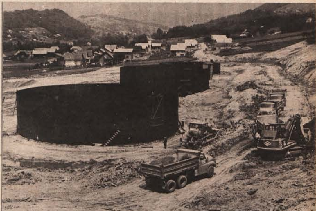
Skladišče goriva za novo elektrarno obsega tri velike cisterne s po 6500 kub. metrov in bodo vanje lahko uskladiščili okoli 20.000 ton goriva.
