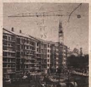
V nevarnosti je „Akcija 26.000 stanovanj“. Posnetek je z Ragske ceste v Novem mestu.
