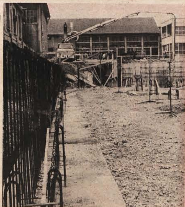
Gradbišče poslopja za nov papirni stroj S III v tovarni papirja in celuloze Djuro Salaj v Krškem.
