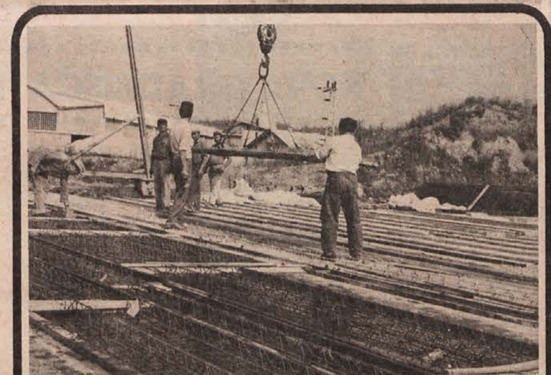
Opažne betonske plošče, ki jih izdeluje IGM SAVA v Krškem, so vse bolj iskane, saj se z njimi poenostavi gradnja stropov.
