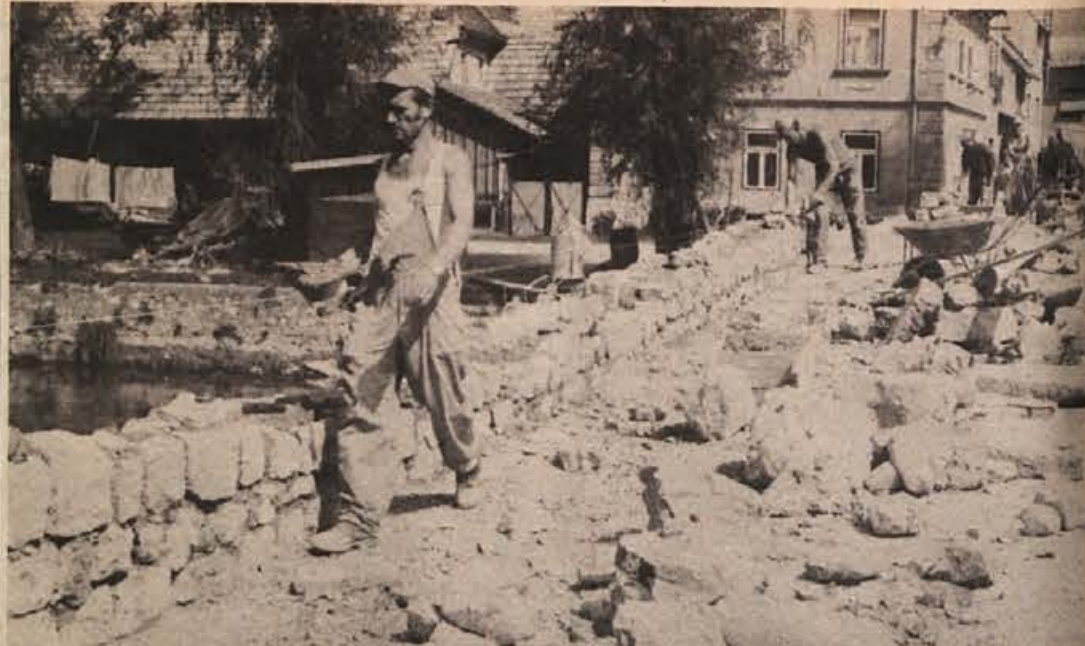
Veliki ribniški most obnavljajo. Z njega je že odpadalo kamenje in po njem je že dolgo prepovedan veslovni promet. Ta most je tudi ena izmed ribniških zanimivosti. (Foto: J. Primc)
