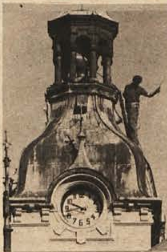
Stolp starinskega novomeškega Rotovža so pred kratkim nanovo »preoblekli«. Nevarno delo so delavci opravljali več dni. Upajo, da bo ta sveža barva vzdržala nekaj desetletij. (Foto: Zvone Seruga)
