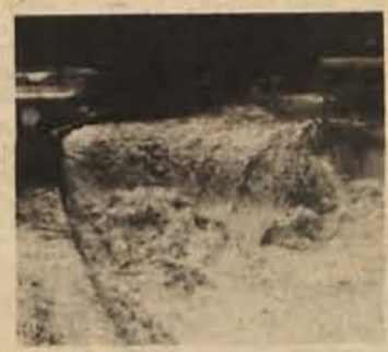
To pa je kopitarniški jez na Sevnici. Nihče v tovarni se ni spomnil, da bi ob naraslem hudourniku dvignili zapornice! Voda si je seveda izbrala pot čez travnik.
