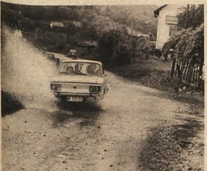
Kakšna cesta drži skozi Ivanjo vas, kaže posnetek: ob deževju poplavljen, kanal zamašen, makadam uničen. (Foto: Polde Pungerčar)
