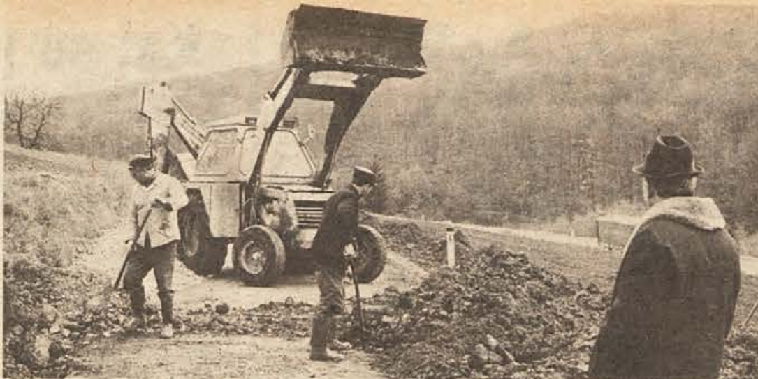
Vožnja po karteljevskem priključku bo varnejša. Delavci novomeškega Cestnega podjetja so najprej „obsekali“ nepregledni ovinek, nato pa cesto razširili za dva metra vse do nadvoznega mostu. Zavoljo teh del so se mnogi v Ljubljano namenjeni avtomobilisti odločali za vožnjo prek Mačkovca. (Foto: Sandi Mikulan)
