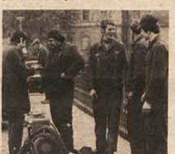
S krpanjem kandijskega mostu ne bomo rešili prometnih težav.
