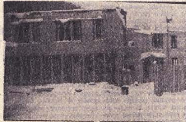
Gradbišče novega, prepotrebnege zdravstvenega doma v Krškem je prekril sneg... Dogovorjeno je bilo, da bo stavba pred zimsko pod streho in uprava doma je upravičeno pričakovala, da bo novi dom res pokrit pred prvimi snegom — zgodilo pa se je drugače
