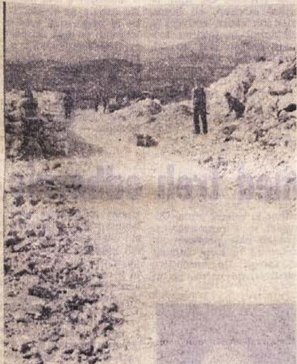
Poročali smo že, da se dela na obnovi gorjanske ceste (Metlika—Novo mesto) nadaljujejo. Računajo, da bodo gotova letos do 29. novembra. Prav zdaj je v polnem razmahu dejavnost na odseku od Suhorja do Vahte. Na sliki: pri Hrastu sekajo cestni ovinek.
