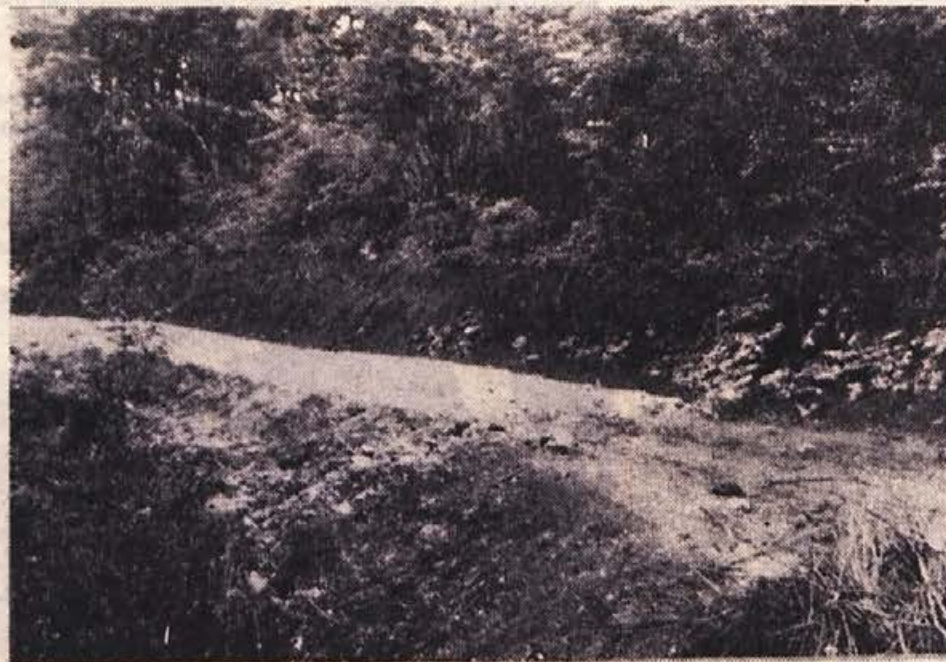
Do tod je bila lani dograjena gozdna cesta Ban — Ravna gora, ki jo gradi Kmetijska zadruga Novo mesto. Letos dela nadaljujejo, in kot vse kaže, bo cesta prihodnje leto dograjena
