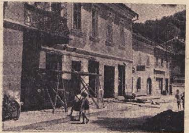
Trgovsko podjetje v Sevnici je že pričelo preurejati prostore poslovalnice na trgu, v kateri je vedno velik vrvež. Prav kmalu se bo spremenila v pravcato blagovno hišo
