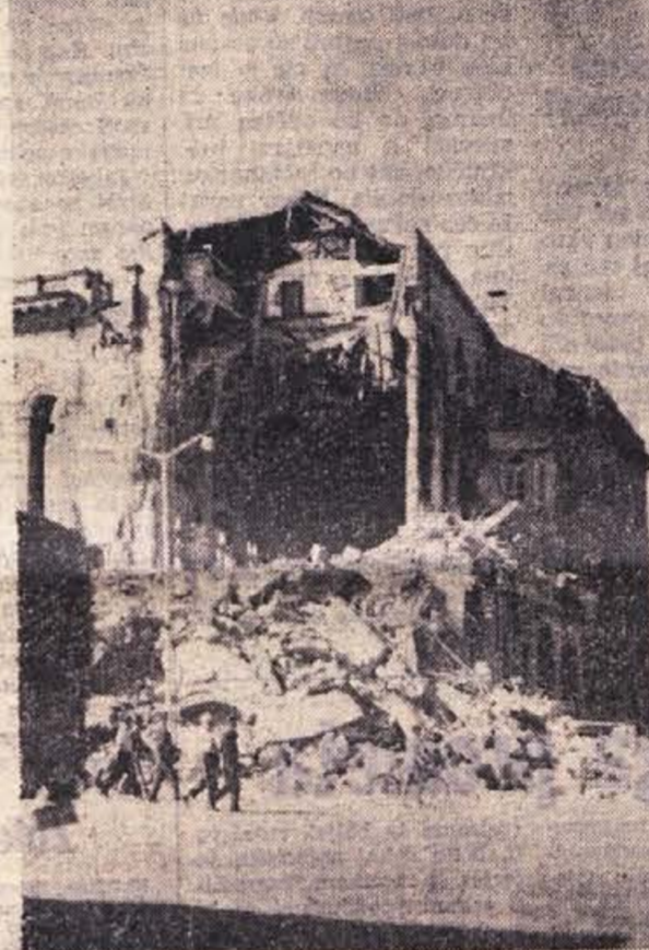
Tak je dom JLA v Skopju danes: kar še stoji, je polno nevarnih razpok. Dva lestena, težka po 1200 kg, pa še vedno visita na oboku velike dvorane...
