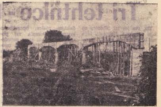
Pogled na gradbišče novih proizvodnih prostorov za žago lesne industrije Zora v Črnomlju
