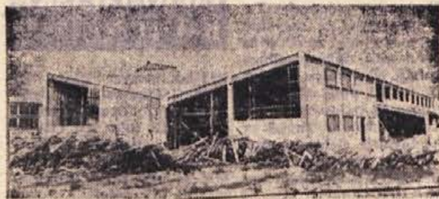
Novo stavba Novolesovega obrata drobnega poštstva je ob tovarni vezanih plošč v Straži zrasla skoraj čez noč.
