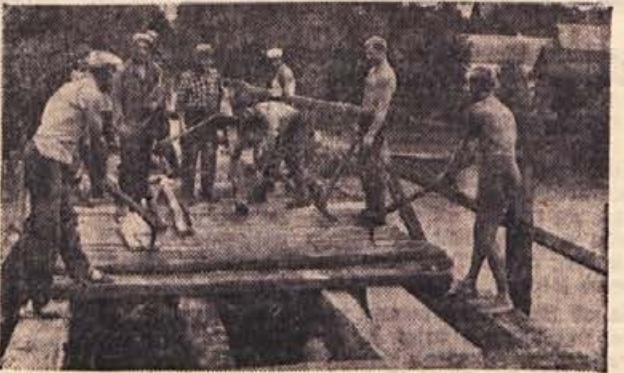
Prebivalci so pri obnovi mostu na Borštu pomagali s prostovoljnim delom
