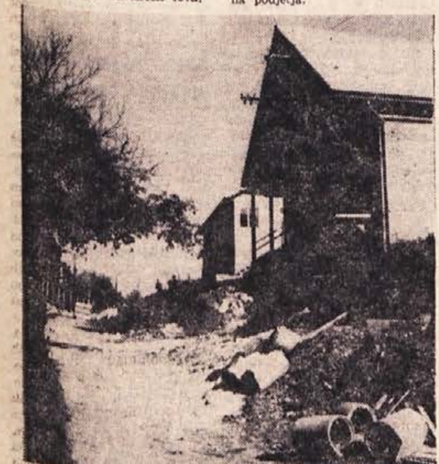
Komunalna dela v Trebnjem so prav te jesenske dni dosegla višek. Med drugim urejajo te dni kanalizacijo v smeri, kjer rase novo naselje, kot prikazuje slika
