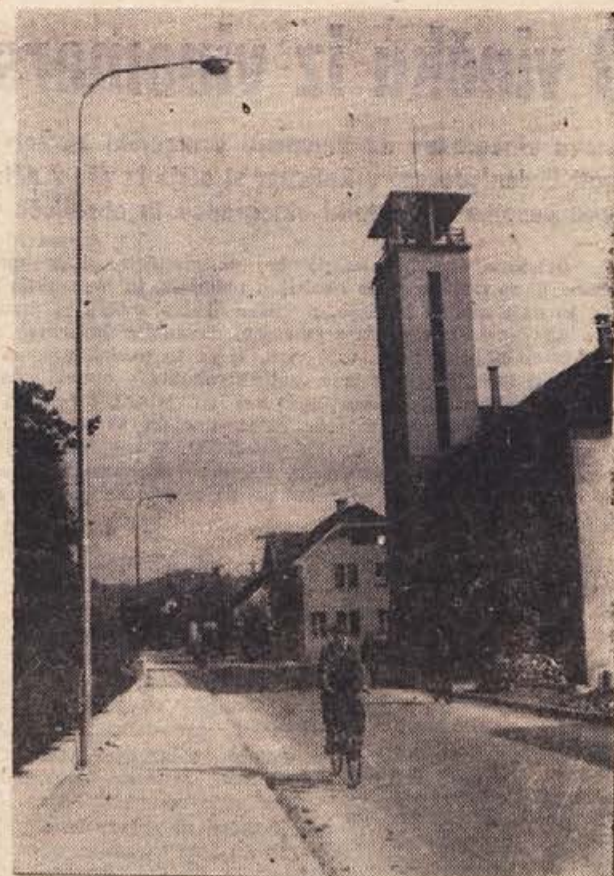
Komunalna dejavnost v sevnški občini je precej razgibana. V Sevnici so v zadnjem času med drugim dobili asfaltirano cesto, javno razsvetljavo, nedavno tega pa so uredili tudi pločnike. Na ureditev čaka že močno obrabljen in razrahljan leseni most čez Savo.
