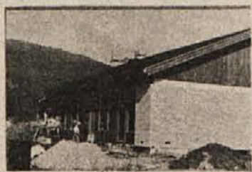
JULIJA VRTEC — V Stari cerkvi pri Kočevju te dni dokončujejo vrtec za 60 otrok. Dela napredujejo po načrtih. Zamude ni. (Foto: Primc)
