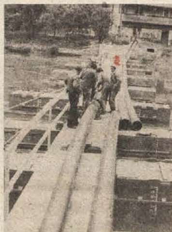
MOST ZA CEVI – Sredi preteklega tedna je preko Krke v Kandiji zrasel nov most, ki so ga postavili delavci Vodnogospodarskega podjetja Novo mesto. Pontonski most je služil zato, da so na njem sestavili kanalizacijske cevi, ki jih bodo tako sestavljene spustili v vodo, potapljači Kluba za podvodne aktivnosti pa jih bodo zasidrati v dno. Kot obljublajo izvajalci, bodo cevi „S“ kanala pričele služiti namenu že spomladi prihodnjega leta. (Foto: J. P.)
