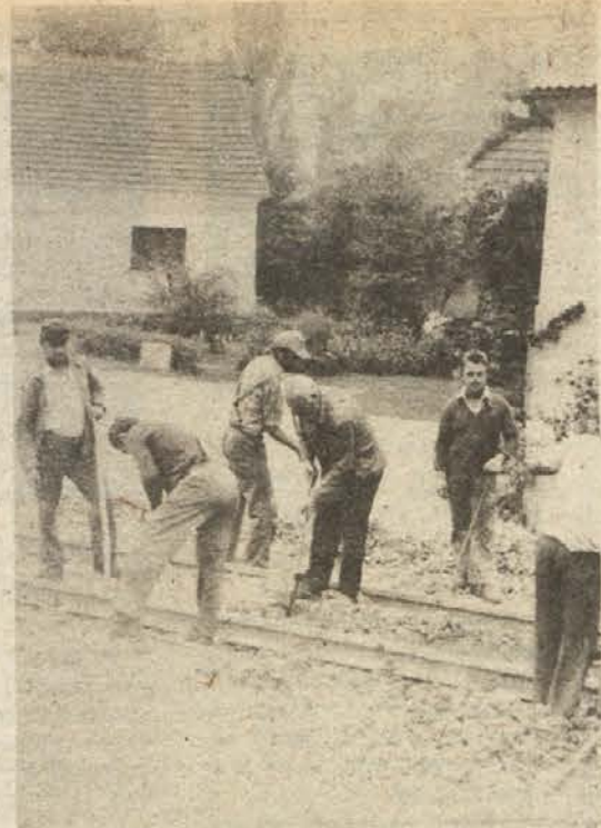
BREZ ZASTOJEV - Progovni delavci so delali ponoči, da so zamenjali trdnice na križanju z obsavsko magistralko pri Boštanju. Tudi drugi prehod, na dosti manj prometni cesti v mestu, so usposobili v enem dopoldnevu. Pripravljenega semafora skoraj niso rabili. (Foto: A. Železnik)
