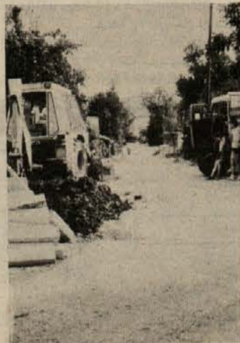
ASFALT NA HRIBU — Končno so tudi prebivalci Tomiščeve in Brodaričeve ceste na metliškem Hribu dočakali asfalt. Konec prejšnjega tedna je bilo vse pripravljeno za asfaltiranje teh cest. Seveda brez izdatnega prispevka prebivalcev tudi na Hribu ne bi bilo asfalta.
