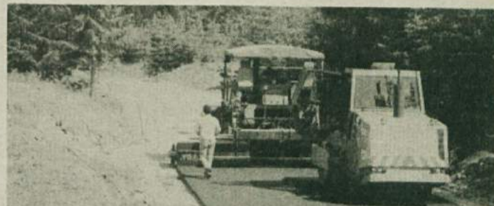
KONČNO ASFALT PROTI SINJEMU VRHU - Konec minulega tedna so si lahko prebivalci Sinjega Vrha in okoliških vasi vsaj delno oddahnili, kajti asfaltirali so prvi odsek ceste od Vinice proti Sinjemu Vrhu. Gre za 2.200 metrov dolg odsek regionalne ceste, za katero posodobitev je denar namenila republika. V letošnjem letu naj bi bil - takšne so vsaj obljube - asfalt do Sinjega Vrha, da pa bo končno asfaltirana vsa belokranjska obkoljska magistrala, bo potrebno posodobiti še nekaj kilometrov ceste do Starega trga. Prebivalci tamkajšnjih naselij, ki so bili dolga leta zapostavljeni, upajo, da se bo to zgodilo čimprej. (Foto: M.B.-J.)
