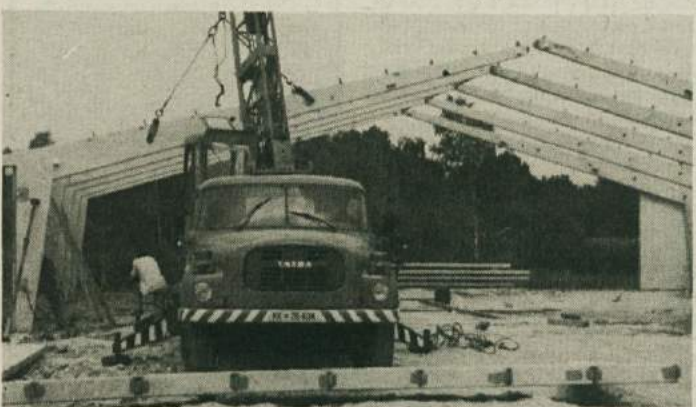
"ŠTALCA" ZA LETALA - Hangar v Prilozju, širok 15 in dolg 20 metrov, bo gotov v začetku avgusta. V Aeroklubu Bela krajina načrtujejo, da bodo letos na letališču uredili celotno infrastrukturo, z urejanjem ostalih objektov in okolice pa bodo nadaljevali prihodnje leto. (Foto: M.B.-J.)
