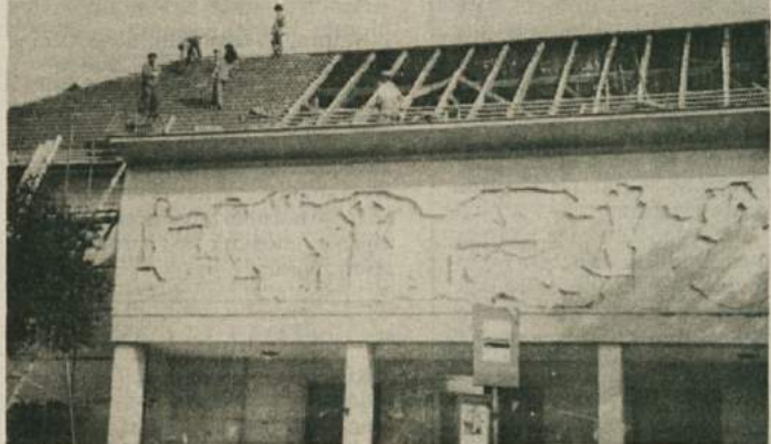
KULTURNI DOM DOBIVA LEPSHO PODOBO - Črnomaljski Begrad se je nedavno lotil temeljite prenove zunanjsčine kulturnega doma v Črnomlju. Še to jesen bo prenovil ostrešje, kritino, fasado, stekleno steno, strelovod in kanalizacijo, spomladi pa uredil še ploščad pred domom ter med domom in pošto. V načrtu je tudi ureditev parka za domove za predstave na prostem, ki pa bo zaradi pomanjkanja denarja morala še počakati. Tokratna nalozba bo veljala 12 milijonov tolarjev, denar pa bodo prispevali skupščina občine, ministrstvo za kulturo in Zavod za izobraževanje in kulturo. (Foto: M.B.-J.)
