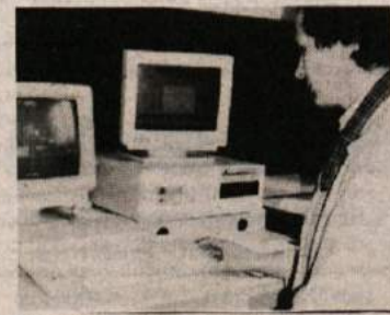
KONTROLNI CENTER — Jože Bašelj, tehnični direktor v Komunalni, lahko v vsakem trenutku na računalnik priključi enega od večjih vodnih črpalnic in ugotovi, kakšno je stanje. Vlaganje v posodobitev in strokovnost se Komunalni obrestuje. (Foto: T. Jakše)
