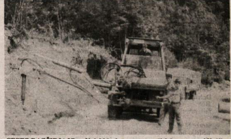
CESTO RAZŠIRJAJO — Vojaki že dva meseca razširjajo cesto med Kužljem in Mirtoviči. Delo lepo napreduje in ga bodo končali do roka, se pravi čez mesec dni. Ta cestni odsek, dolg okoli 7 km, bo nato asfaltiralo cestno podjetje za Reke. Tako bo končno le asfaltirana vsa cesta med Brodom na Kolpi in Osilnicu. Res pa je tudi, da je ponekod stari asfalt že zelo slab in bi bilo ceno, predvsem skozi naselja na hrvaški strani Kolpe, potrebno spet preliči z asfaltom. Na fotografiji: vojaki vrtajo, da bodo zaminirali skale, saj je bila doslej cesta v kanjonu Kolpe zelo ozka. (Foto: J. Prime)
